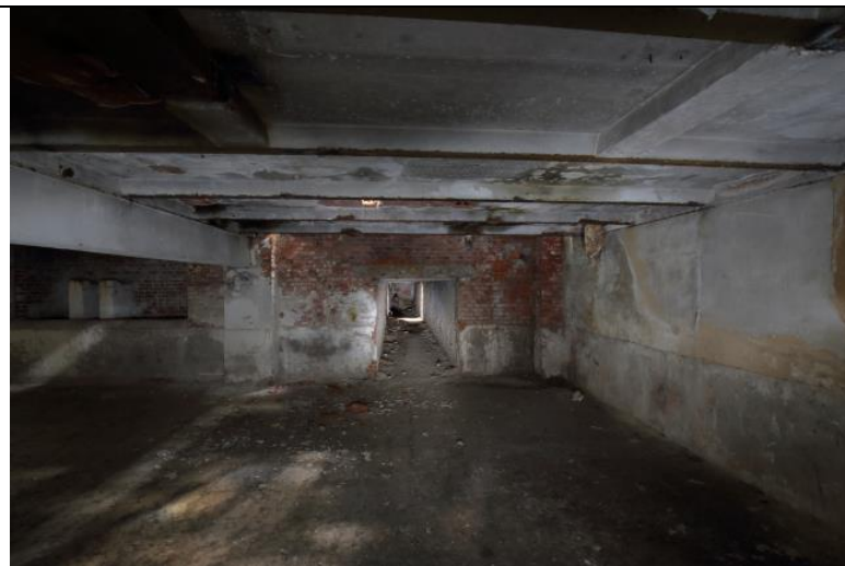
Abb. 4: Kellergeschoß. Zugang zum Vereinsgebäude
