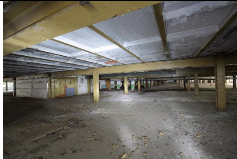
Abb. 3: Kellergeschoß, ehem. Sozialräume und Lager
