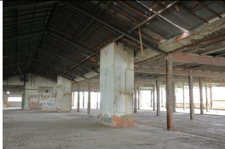
Abb. 5: Erdgeschoss, unter dem Lichthof, ehem. Kleinteillakierung
