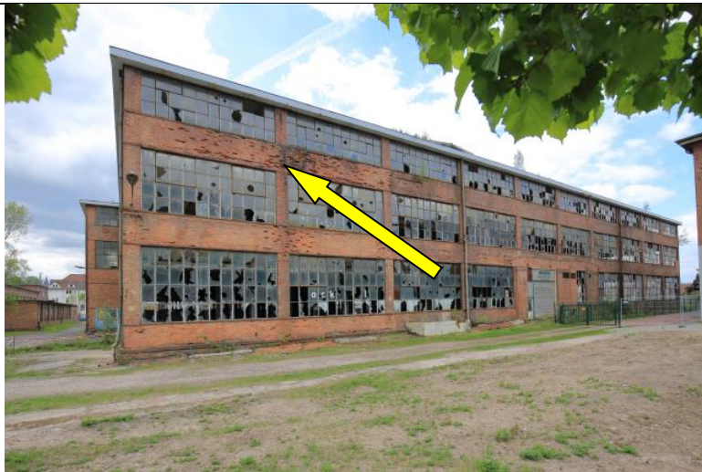
Abb. 15: Fledermausquartier an der Nordfassade
