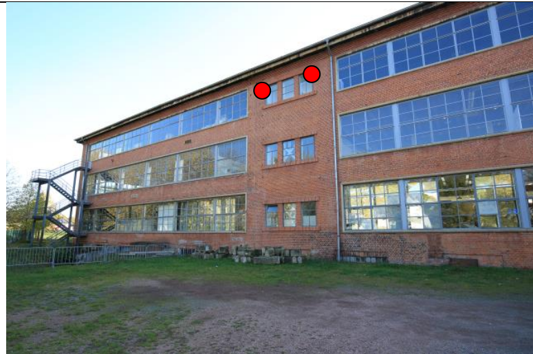
Abb. 29: Zwei Ersatzquartiere Museum Nordfassade
