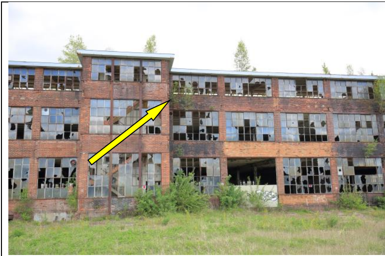
Abb. 17: Fledermausquartier Westfassade am Treppenhaus
