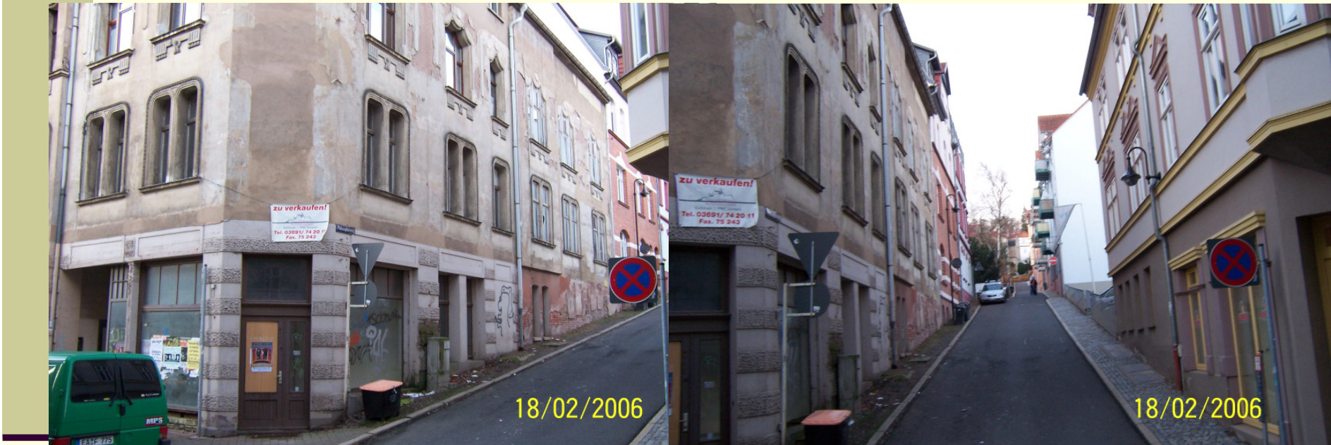
Ecke Marienstraße 6 mit Seitenflügel Modernisierung und Abbruch
