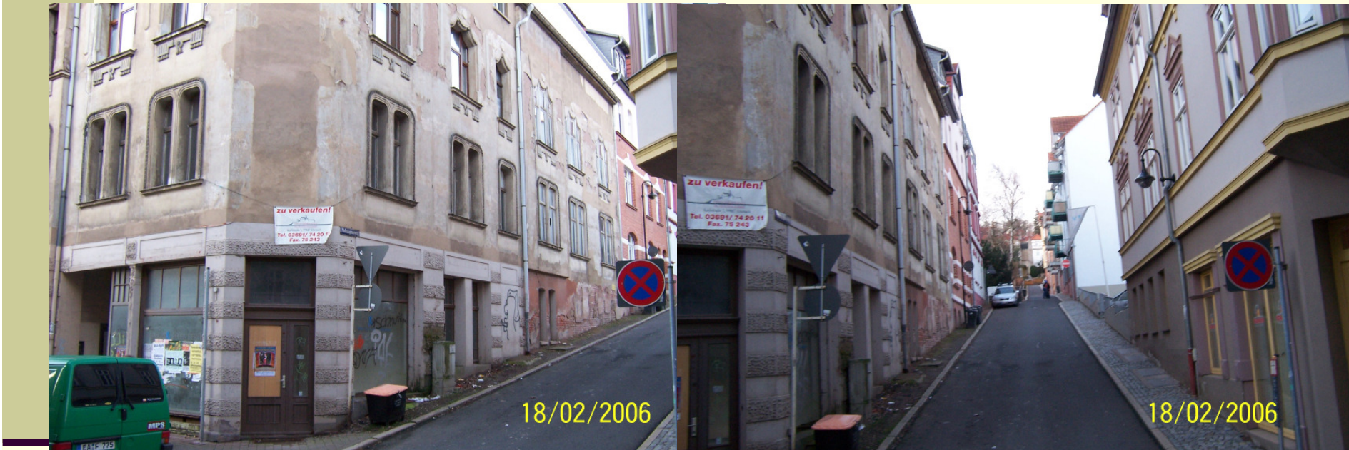
Ecke Marienstraße 6 mit Seitenflügel Modernisierung und Abbruch
