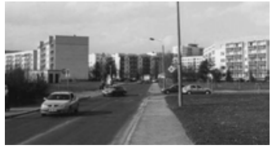
Geschäftshäuser an der Stregdaer Allee
