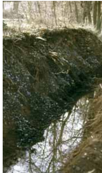
Die so genannte Stollen-Rösche
