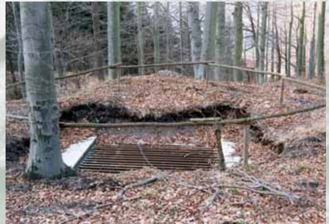
Vorschriftsmäßig gesicherter Kupferschiefer-Bergbauschacht am Rennsteig bei Neuenhof
