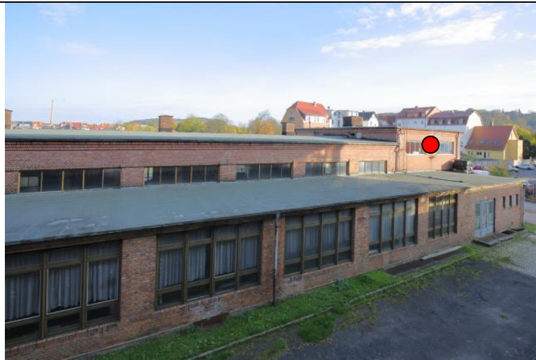
Abb. 31: Ein Ersatzquartier Vereinsgebäude Westfassade
