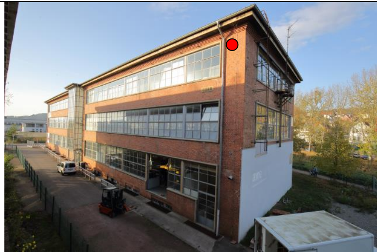
Abb. 28: Ein Ersatzquartier Museum Südfassade (Ostseite)
