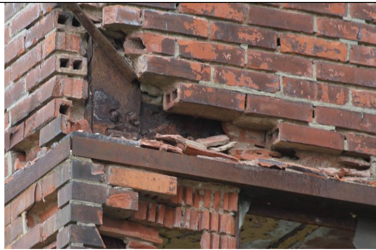
Abb. 8: Beschädigte Hohlziegelwand.
