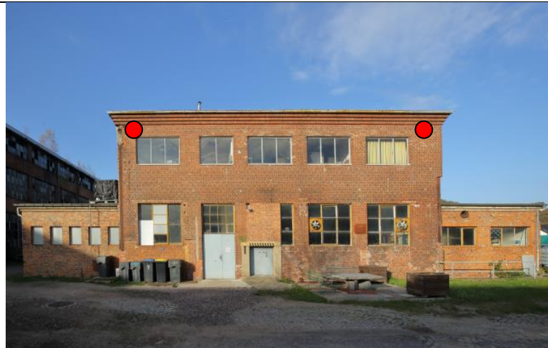
Abb. 30: Zwei Ersatzquartiere Vereinsgebäude Südseite
