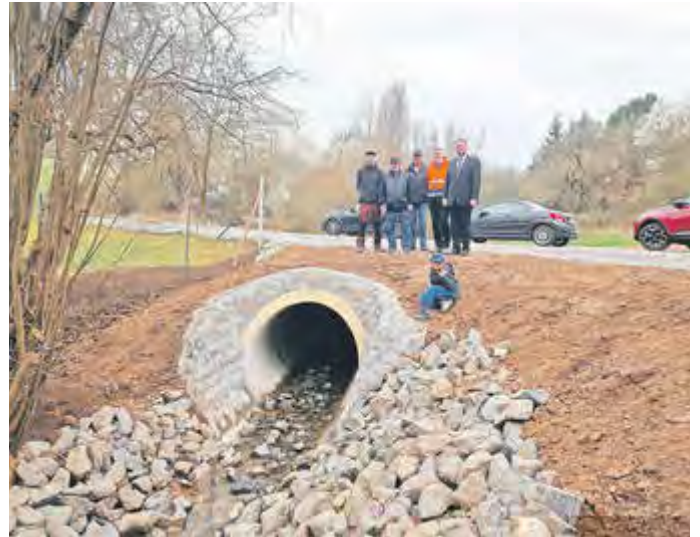
Bürgermeister Christoph Ihling (v.r.n.l.), Bauingenieur Thore von Erichsen, Ortsteilratsmitglied Jürgen Koch, Stockhausens Ortsteilbürgermeister Dieter Suck und Tobias Heß, ebenfalls vom Ortsteilrat, und Moritz (vorn) kamen zur Übergabe der Brücke.
