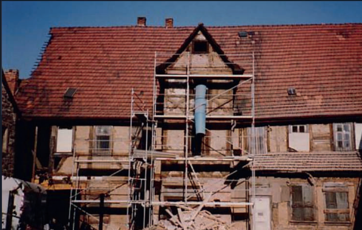
Georgenstraße 43, Hellgrevenhof, Hofseite - vor der Sanierung
