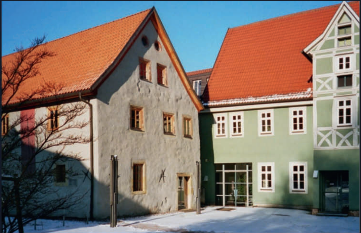
Georgenstraße 43, Hellgrevenhof, Kemenate und Hofseite - nach der Sanierung
