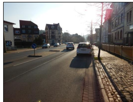
Langensalzaer Straße (B 19)
