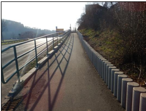
Langensalzaer Straße (B 19)
