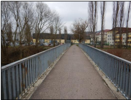
Brücke Tiefenbacher Allee / Amrastraße
