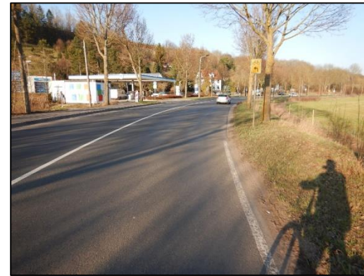
Langensalzaer Straße (B 19)
