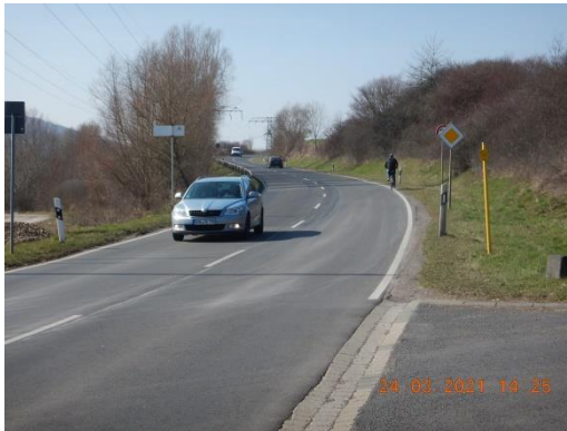
Stedtfelder Straße (L 1021), außerorts
