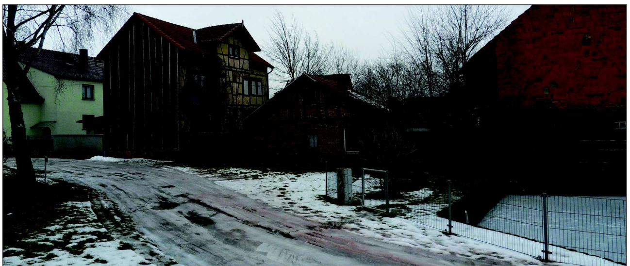
Abb. 26 Baufällige Bestandsbauwerke und Pferdeteich, Quelle: Feistel
