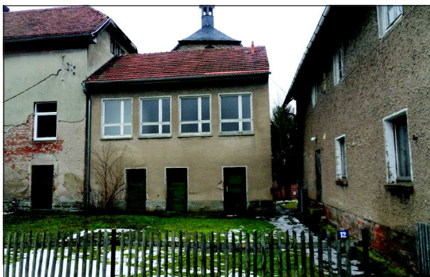
Abb. 22 Südlicher Anbau mit fehlender Sichtbeziehung zur Kirche, Quelle: Feistel
