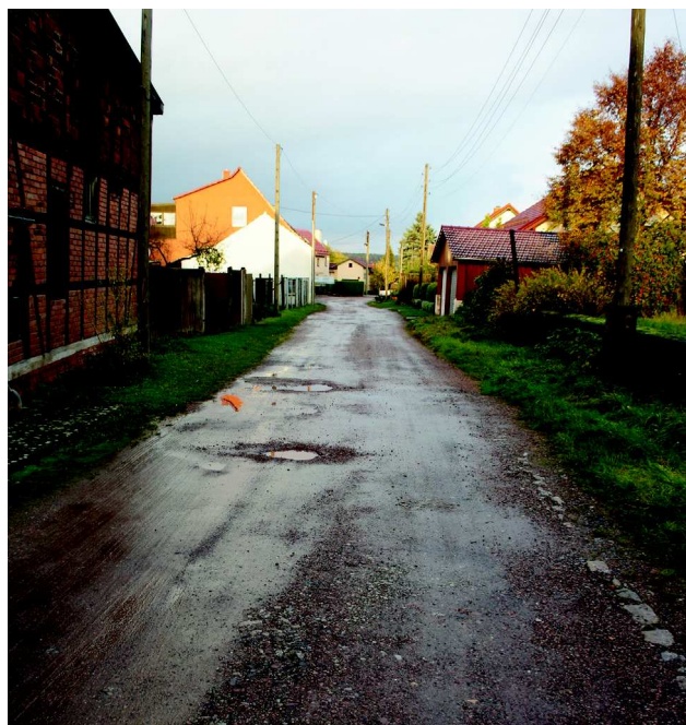
Abb. 37 Unsanierter Straßenzug ‚Am Teich‘, Quelle: Eigene Aufnahme
