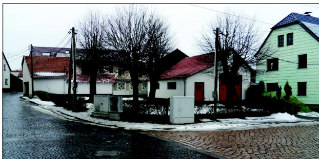
Abb. 21 Grünfläche am Anger mit Feuerwehrgarage, Quelle: Feistel
