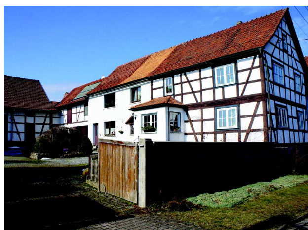
Abb. 15 Ortstypische Hofform mit Fassadengestaltung, Quelle: Eigene Aufnahme
