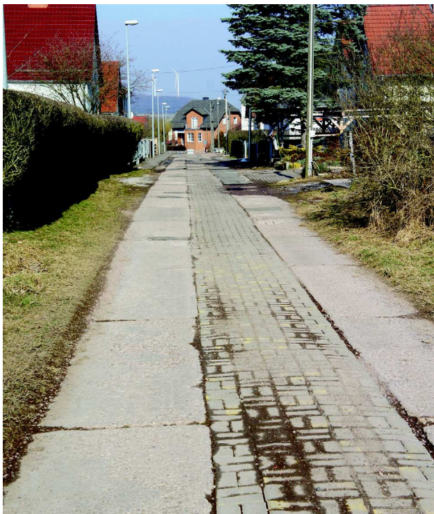
Abb. 38 Unsanierter Straßenzug ‚Windmühlenweg‘; Quelle: Eigene Aufnahme
