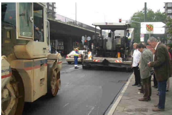
Fotos: Einbau lärmindernder Belag in Düsseldorf
