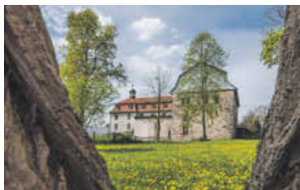
Fotograf - Rainer Schade
