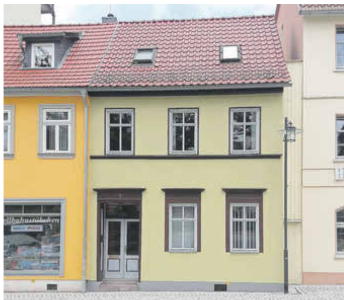
Marienstraße 5 nach der Fassadensanierung
